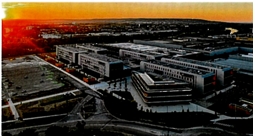
Les nouveaux bureaux de Stellantis à Poissy (Yvelines) sont équipés de systèmes de rafraîchissement plus verts que la climatisation, comme des dalles refroidissantes ou des façades ventilées. Photo médiatique
